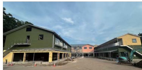
建築中の施設(2024年7月中旬撮影)
